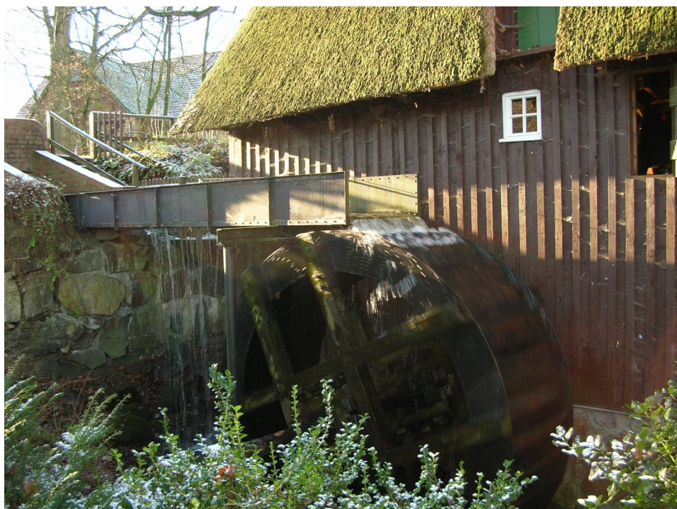
Das Wasserrad der Ovelgönner Mühle, Copyright: unbekannt
